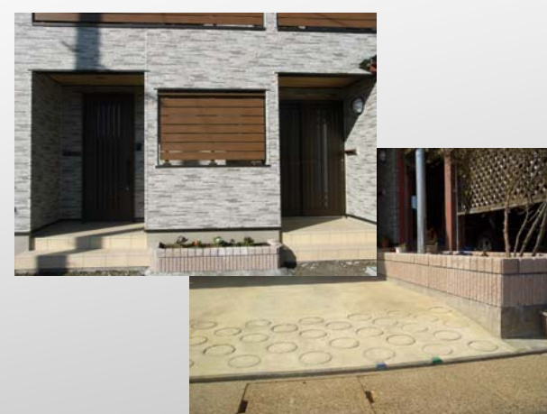
玄関アプローチ/外構施工事例
